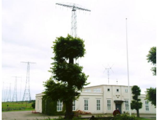
pylônes autoporteurs de 127 m. L'émetteur mécanique de Grimeton est utilisé jusque dans les années 1950 pour les communications télégraphiques transatlantiques avec la station de Long Island, New York, aux États-Unis, puis pour les communications sous-marines jusqu'en 1996. En 1968, un second émetteur est installé, utilisant des techniques à transistor et tubes pour remplacer la machine tournante, à la fréquence de 17,2 kHz avec les mêmes antennes.
